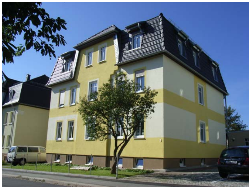
Bild 3: Ein 2. Preis beim ISOVER Energieeffizienz Award 2007 für das Mehrfamilienhaus in Chemnitz
